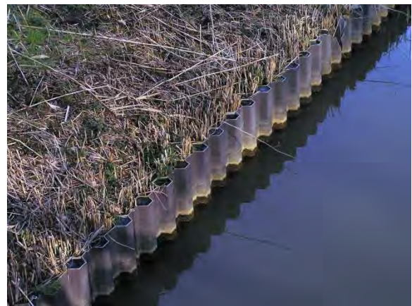
Damwand (Foto Martin Soesbergen)
